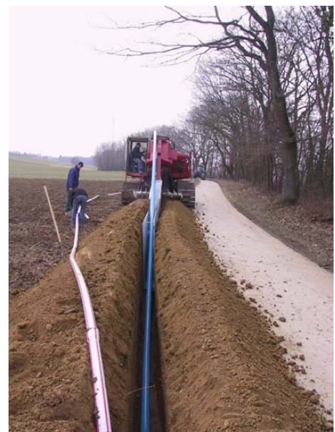
Grabungsarbeiten für das Verlegen der Zuleitung, die die Wass erfassung mit der Pumpstation verbindet, und Verlegen der Förderrohre (Quelle: Amt für Landwirtschaft des Kantons Freiburg)
