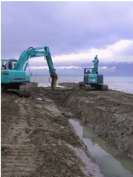
Grabungsarbeiten für das Verlegen der Zuleitung, die die Wass erfassung mit der Pumpstation verbindet, und Verlegen der Förderrohre (Quelle: Amt für Landwirtschaft des Kantons Freiburg)
