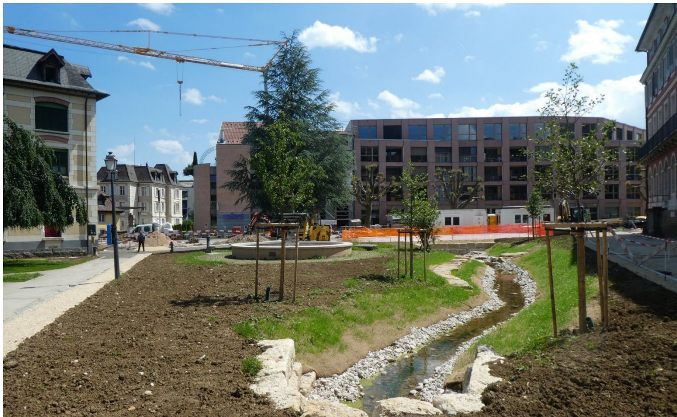
Travaux à la place des Bannelats / Bauarbeiten am Place des Bannelats (2024)
