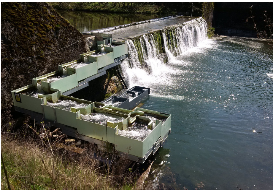
Steffstep an der Töss, d.h. eine temporäre Fischtreppe für den Einsatz an Kleinwasserkraftwerken und sonstigen Querbauwerken, die von der WRH Walter Reist Holding AG entwickelt wurde (Quelle: WRH).
