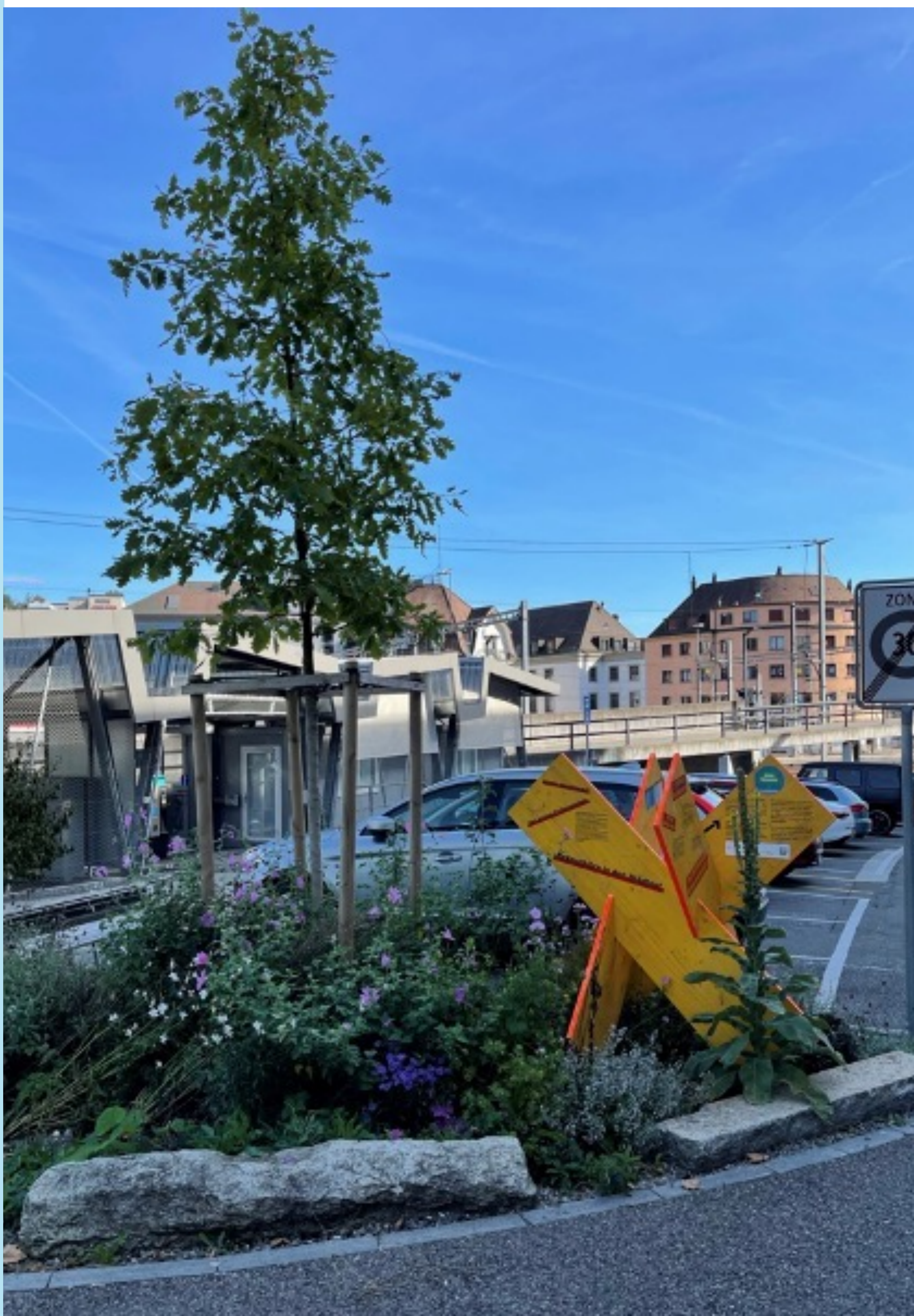
Klimaoase Baden 2021 - Die Fläche wurde vom Asphalt befreit, eine Baumgrube erstellt und nach der Pflanzung der Traubeneiche wurden Stauden- und Pionierpflanzen ergänzt.
