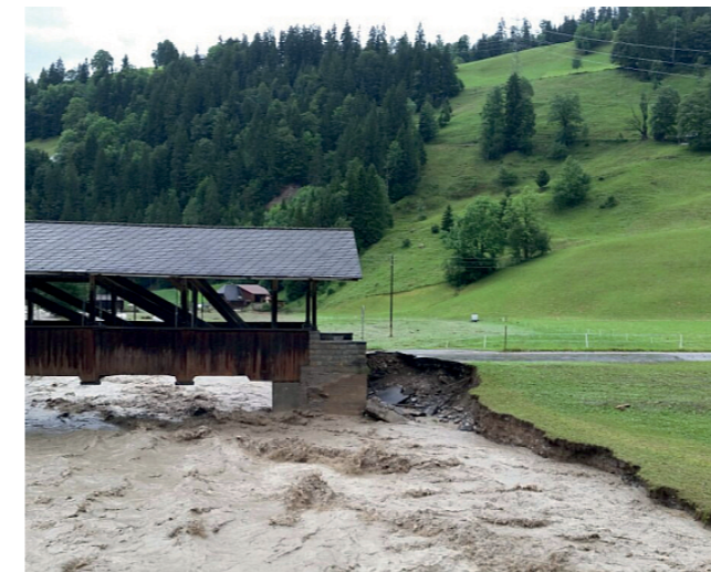
Crue près de Bumbach (BE), juillet 2014
