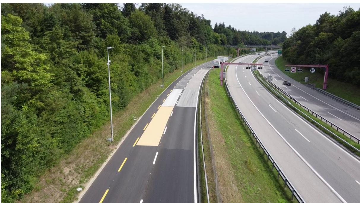
Fig. 1 : Prise de vue par drone de la Neue Murtenstrasse à Berne avec les différents revêtements testés.
