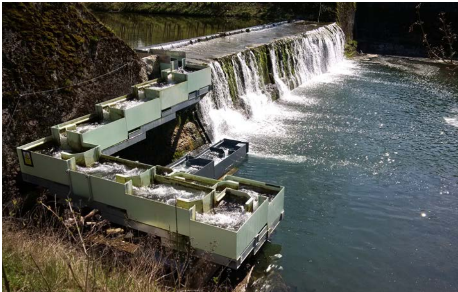
Passé à poissons Steffstep dans la Töss: il s'agit d'une passe à poissons amovible et temporaire développée par la société WRH Walter Reist Holding qui peut être installée au niveau de petites centrales hydrauliques ou d'autres ouvrages transversaux (source: WRH).
