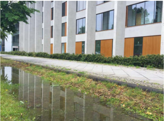
Figure 64 Rétention et infiltration lente à Adlershof
