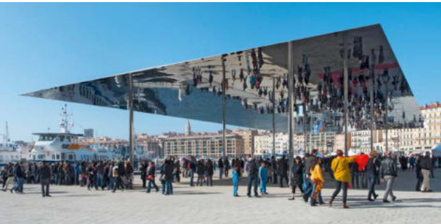
Fig. 86 : L'Ombrière à Marseille
