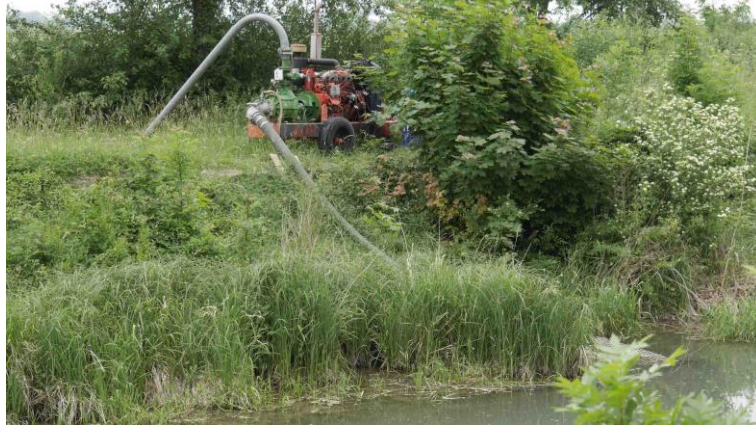
Wasserentnahme mit mobiler Pumpe (Foto: C. Hedinger)
