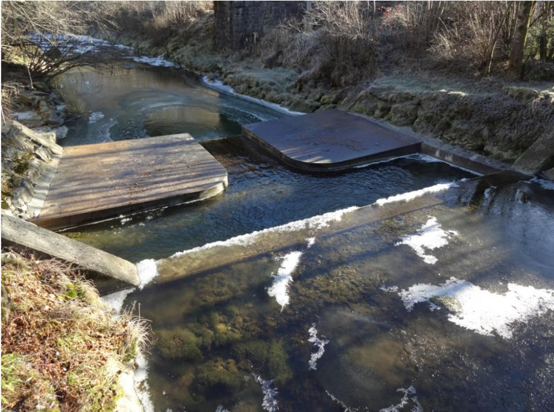
Abbildung 20: Abflussmessstation mit Niederwasserrinne an der Biber bei Biberbrugg © Jörg Hammer, BAFU
