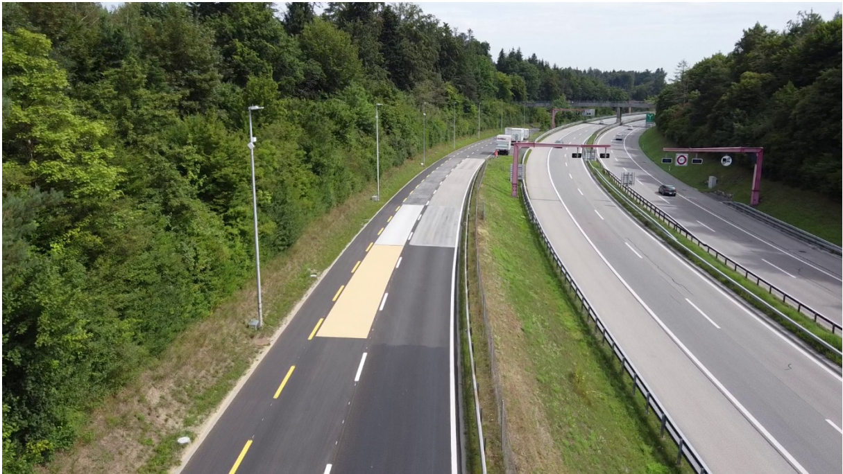
Figura 1: Immagine aerea della nuova Murtenstrasse a Berna con i vari manti di prova
