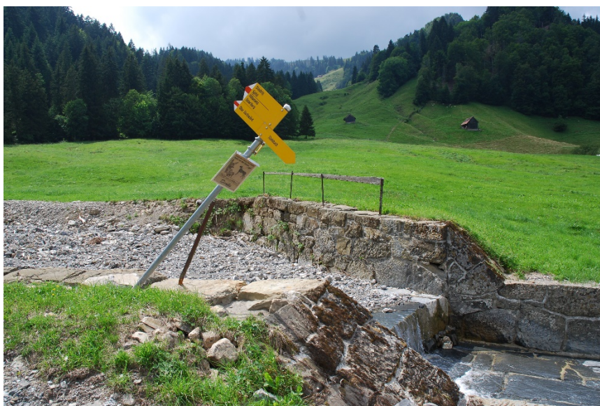
Figura 1: Sito di segnaletica presso Steinbach SZ dopo un'ondata di maltempo © Peter Marty 2007
